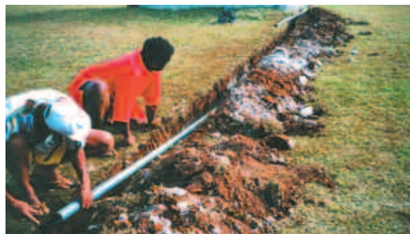
Pose de câbles à Lifou. © IRD / J.-L. Laurent
